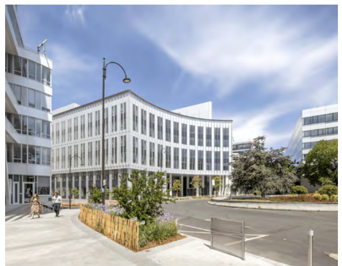
MAYOLY head office in Rueil-Malmaison
